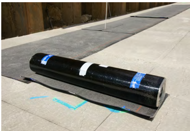
Die wolfseal FBV Dichtungsbahn wird auf der vorbereiteten Sauberkeitsschicht verlegt.
