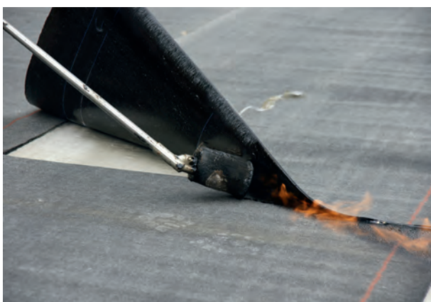
Die Dichtungsbahn wird an den Überlappungen mit Heißluft oder Flamme miteinander verschweißt.
