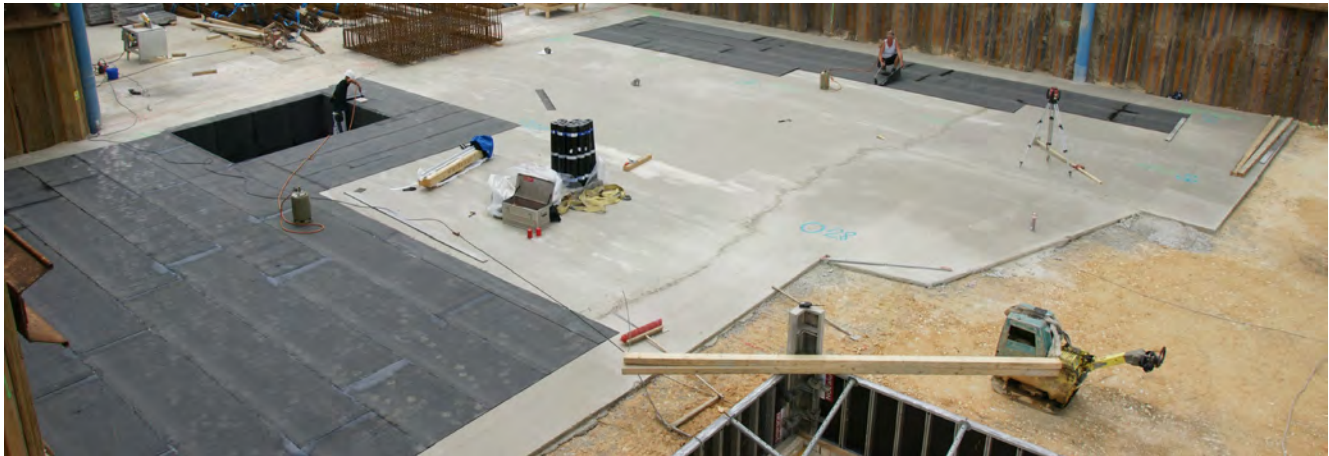
Verarbeiten von wolfseal FBV-Dichtungsbahn unter der Bodenplatte
